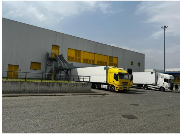
Vista rampe carico/scarico – Ed.06 Ovest - Porzione E
