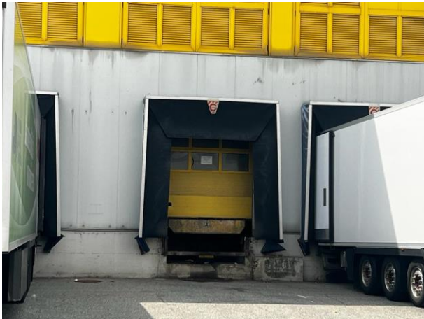
Rampa carico/scarico – Ed.06 Ovest - Porzione E
