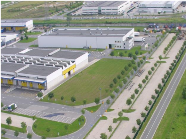
Vista aerea Edificio 06 Ovest
