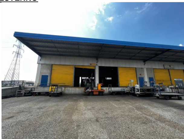
Vista frontale – lato Nord
