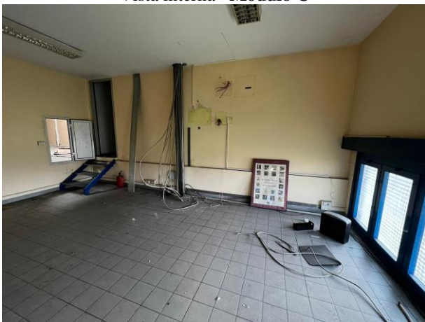
Vista interna – Piano Soppalco - Modulo B
