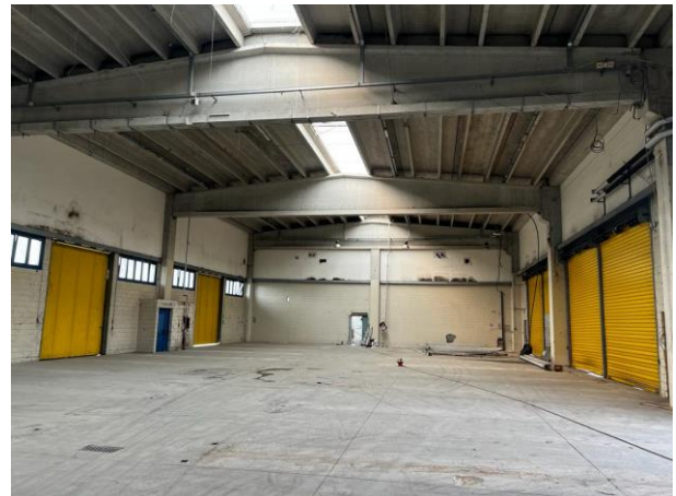
Vista interna – Modulo A
