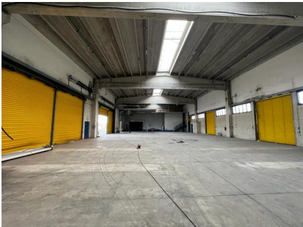
Vista interna – Modulo A
