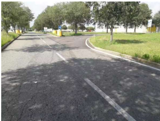
Manto stradale in prossimità della cabina elettrica
