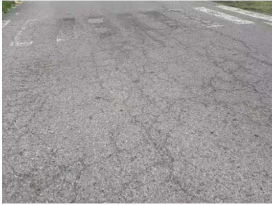
Imbocco per la Rotonda esterna
