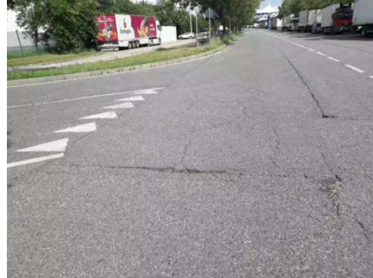
Parte in prossimità dell'imbocco Est verso Edificio 05
