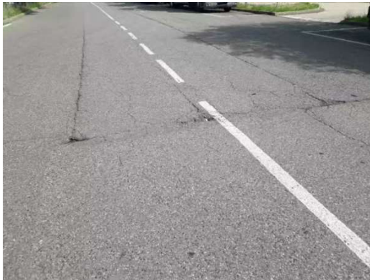
Area tra Edificio 11 lato Ovest ed imbocco Est verso Edificio 05
