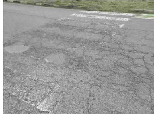
Imbocco per la rotonda esterna – Dettaglio strisce pedonali
