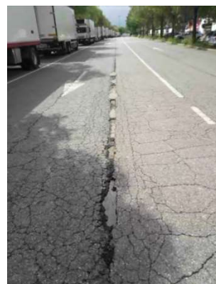
Area nei pressi di Edificio 11 lato Ovest - Dettaglio
