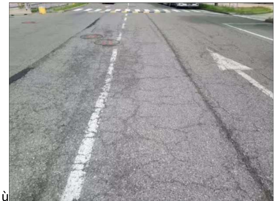
Area tra Edificio 12 – Fessurazioni e pozzetti
