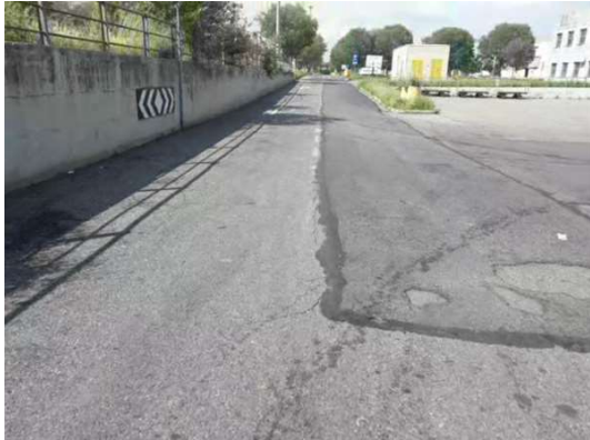
Area parzialmente ricoperta per ridurre avvallamenti in prossimità di Strada Magazzini
