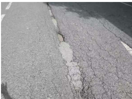
Area nei pressi di Edificio 11 lato Ovest - Dettaglio
