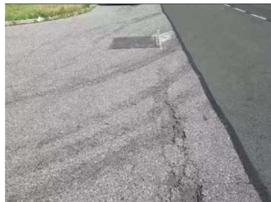
Manto stradale esterno varchi
