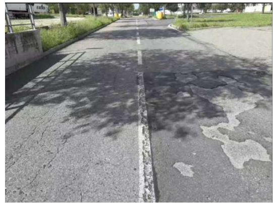
Area parzialmente ricoperta per ridurre avvallamento in prossimità della cabina elettrica
