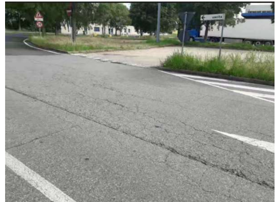
Area tra Edificio 12 e Rotonda – Pressi Ed. 10
