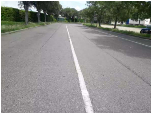
Area tra Edificio 12 e Rotonda – Pressi Ed. 12
