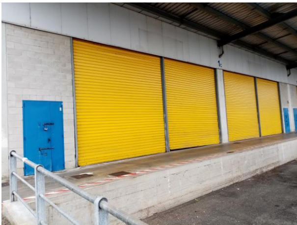
Vista banchina – lato Nord
