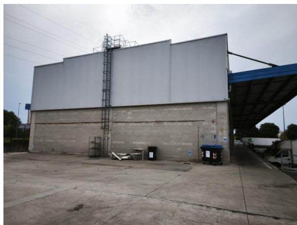
Vista Esterna – lato Est
