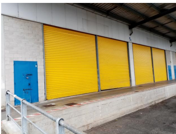
Vista banchina – lato Nord
