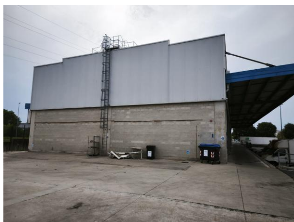
Vista Esterna – lato Est
