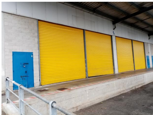
Vista banchina – lato Nord
