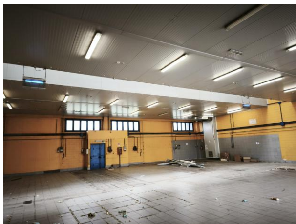
Vista interna – lato Sud
